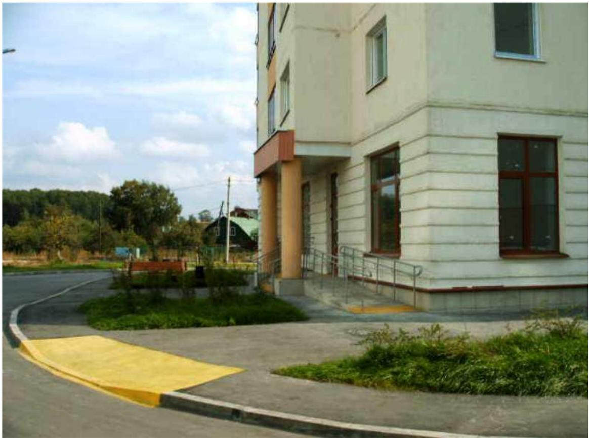
При устройстве съездов с тротуара около здания допускается увеличивать продольный уклон до 10% на протяжении не более 10 м.
