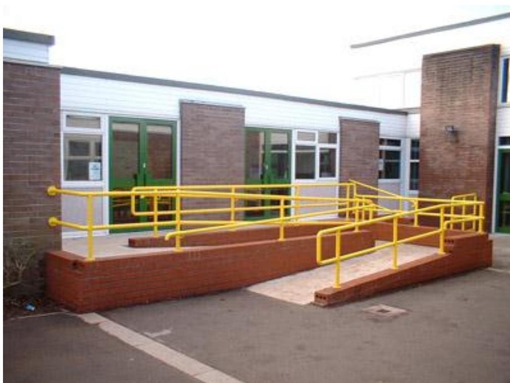
Завершающие части поручня должны быть длиннее марша или наклонной части пандуса на 0,3 м.
