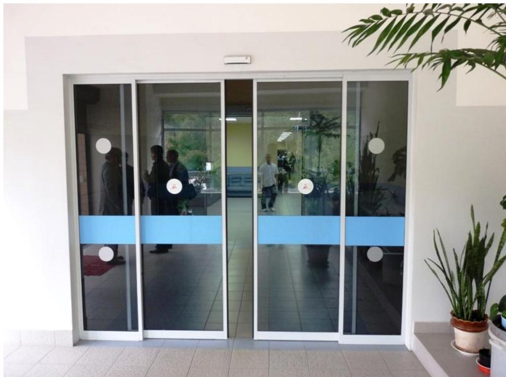
Ширина дверных и открытых проемов в стене, выходов из помещений и из коридоров на лестничную клетку должна быть не менее 0,9 м.
